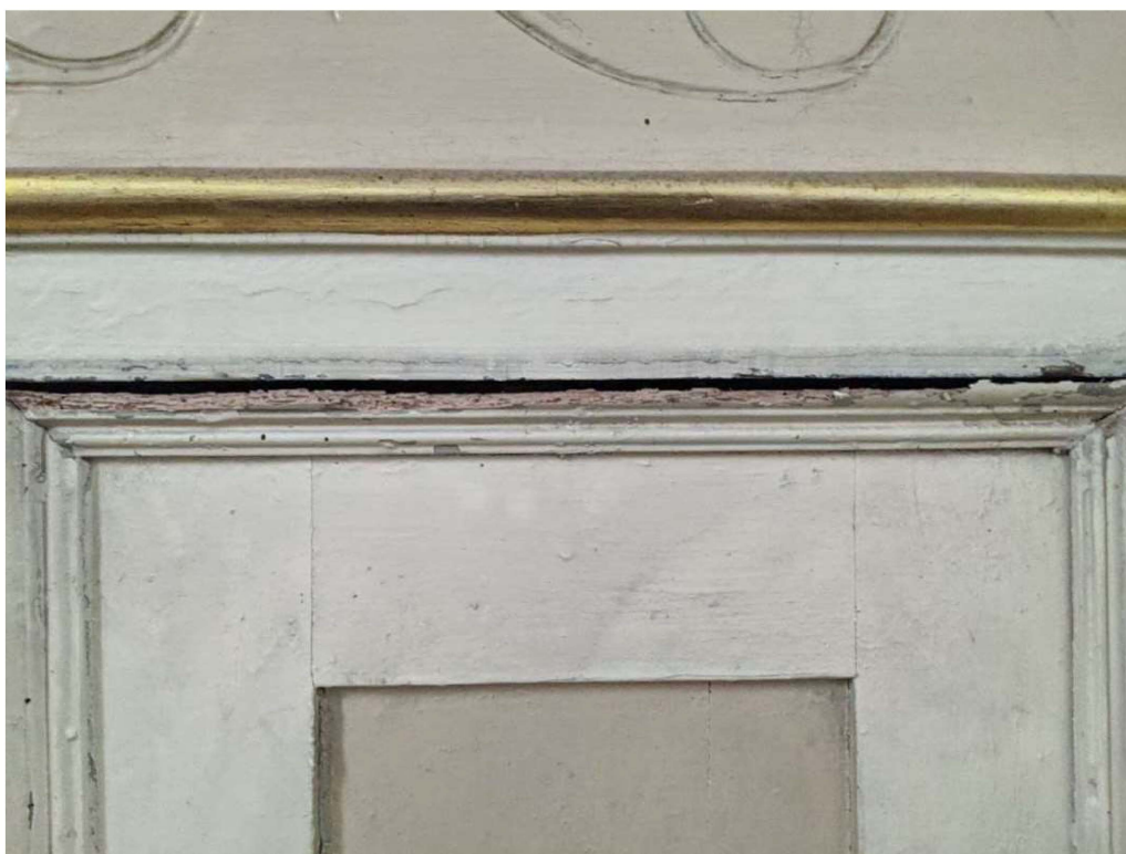
Fot. nr 4 XIX wieczny prospekt organowy i balustrada chóru muzycznego z kościoła p.w. Narodzenia Najświętszej Marii Panny w Mińsku Mazowieckim. Widok zniszczeń struktury drewna spowodowane obecnością insektów.
